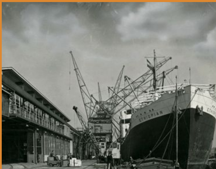
Het poortgebouw volop in gebruik. (Stadsarchief Rotterdam)
