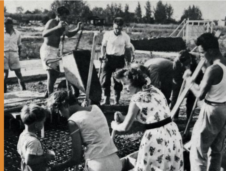
De bouw van bungalows voor en door personeel van Thomsen's Havenbedrijf. (Stadsarchief Rotterdam)
